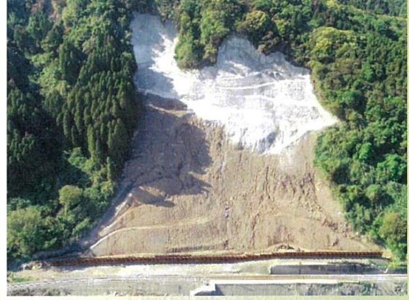
応急仮工事完成全景
