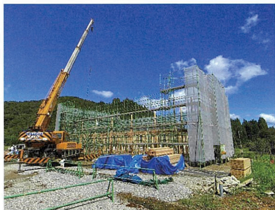
建築工事の様子
