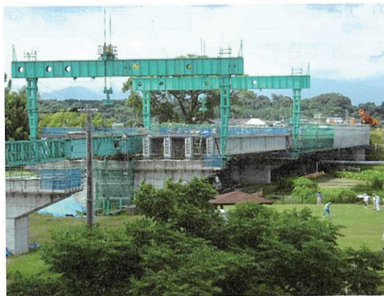
土木工事の様子
