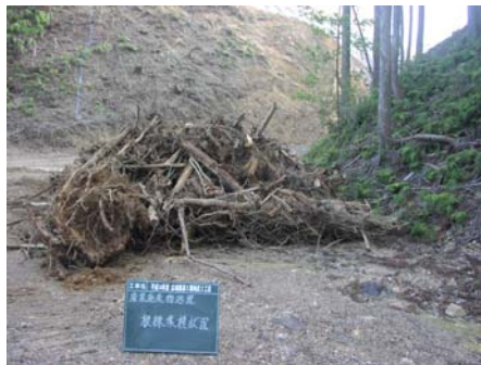
工事施工で発生した伐根材の集積状況
