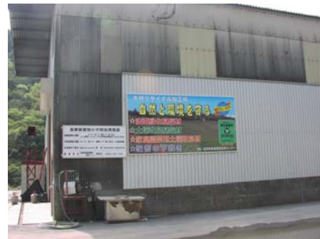
伐根材を再生処理業者へ搬出
