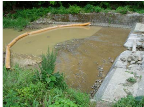
汚濁防止フェンスの設置状況
