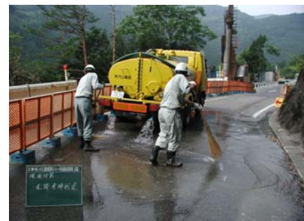
現道の道路清掃状況
